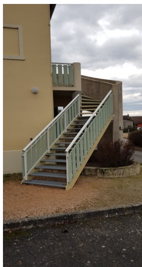
Cure, changement de l'escalier extérieur
