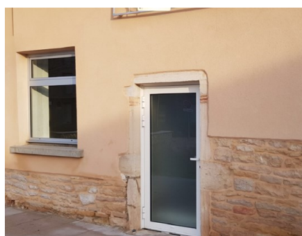
Bâtiment Crédit Agricole, aménagement et installation du cabinet d'orthopédie : détails dans le n°48 de janvier 2021
