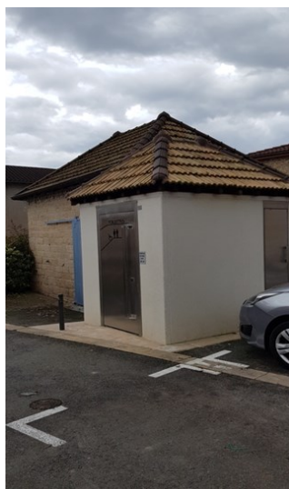
WC publics, place de la mairie : détails dans le n°48 de janvier 2021
