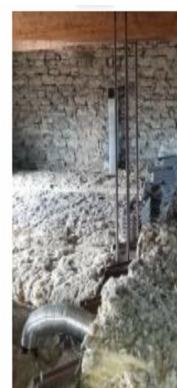
Isolation des combles de la mairie, de l'école et du bâtiment abritant le commerce informatique
