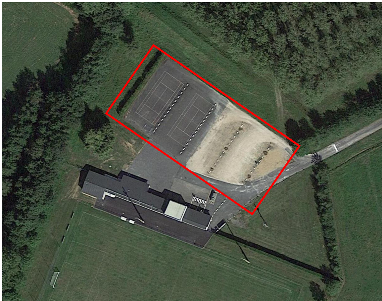
Figure 2 – Parking du stade de la Chassagne
