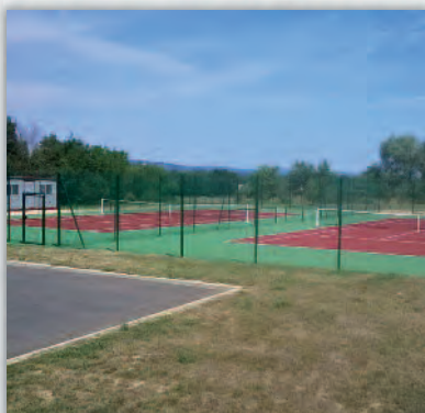
Construction de 2 terrains de tennis
