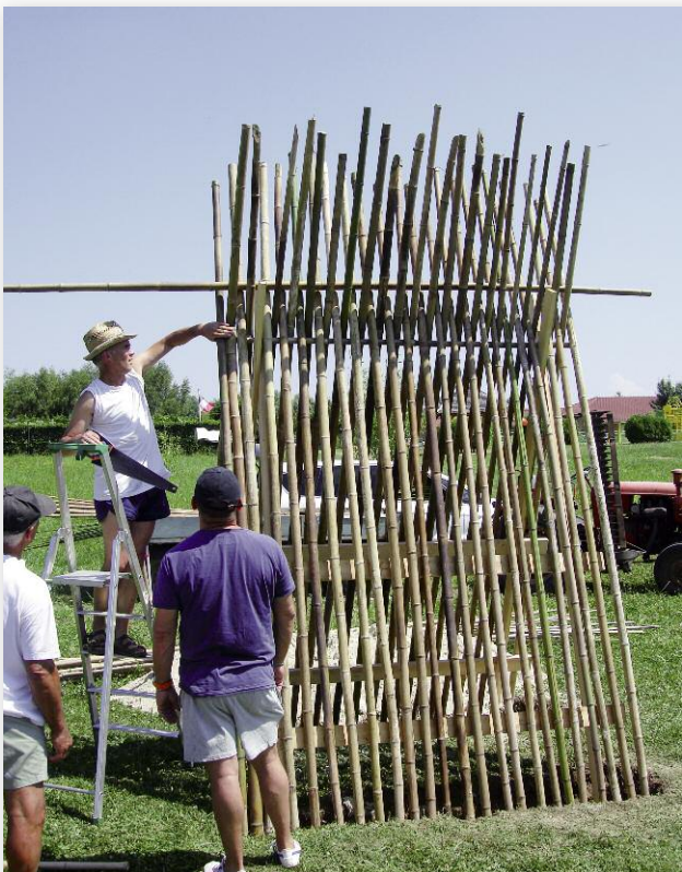
Construction d'une cabane en bambou au parc de loisirs
